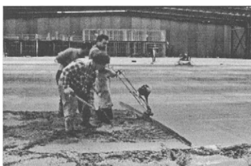
Figure.5 Power float, large area pour
