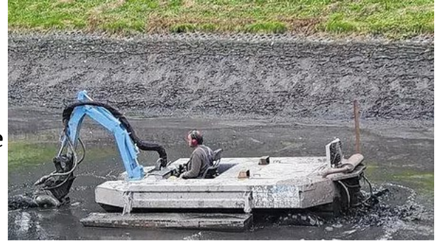
Foto: Andrea Kemmer | Aufwühlender Job: Eckhard Funck quirilt den Schlamm im Becken der Kläranlage Neubrunn mit seinem Amphibienfahrzeug auf, um ihn dann abzusaugen.
