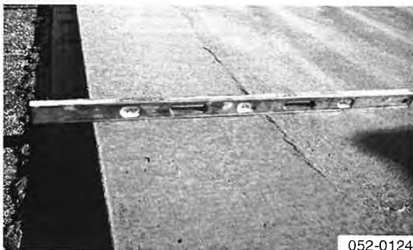
Check edge slump
